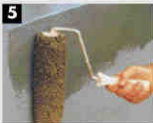
5 Dos manos de pintura de protección con KEIM Concretal-W, a) Mano de fondo diluida b) Mano de acabado sin diluir. Ambas manos a cepillo, rodillo o air-less.
