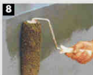
Dos manos de pintura de protección con KEIM Concretal-C. Dos manos sin diluir. Rodillo o air-less.
