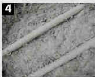
Dos aplicaciones de protección de las armaduras desoxidadas, con KEIM Concretal-MKH. Intervalo mínimo, 3 horas. Primera aplicación, inmediatamente después de desoxidar.
